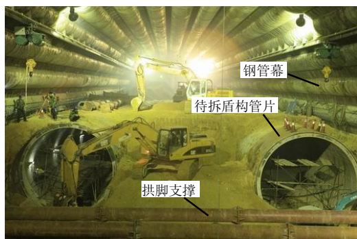
图 3 某地铁车站施工图
